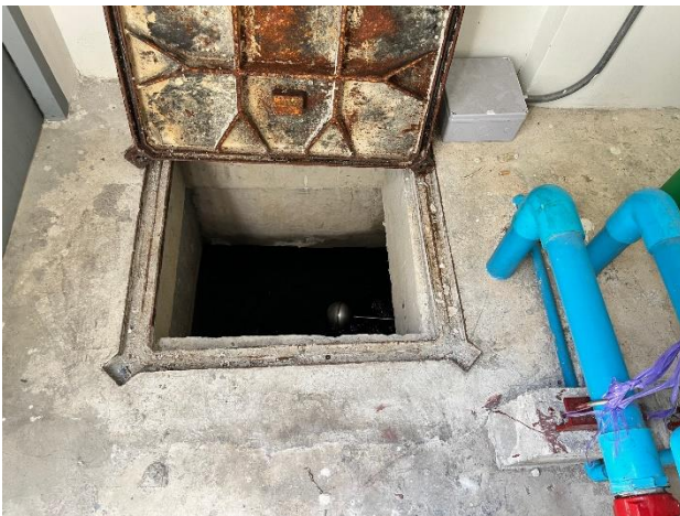
รูปที่ 14 ถังสำรองน้ำใต้ดินโครงการ
