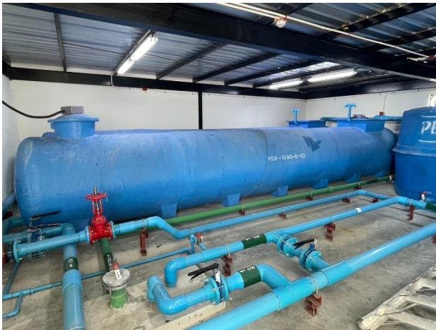
รูปที่ 13 ถังสำรองน้ำบนดาดฟ้าของโครงการ
