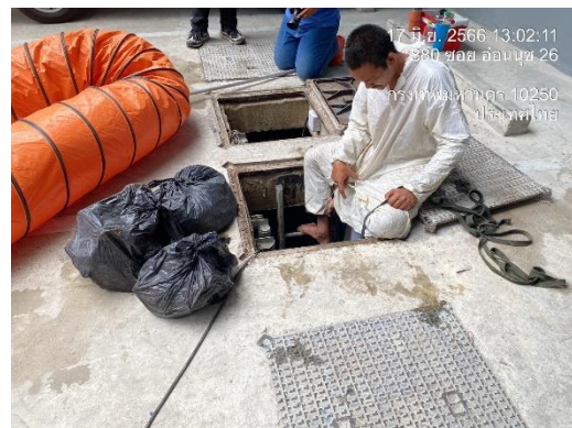
รูปที่ 38 ขุดลอกตะกอนที่ระบายและบ่อพักน้ำ
