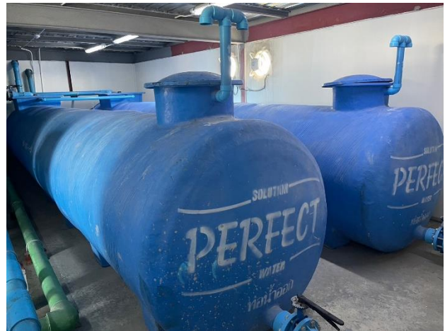
รูปที่ 13 ถังสำรองน้ำบนดาดฟ้าของโครงการ
