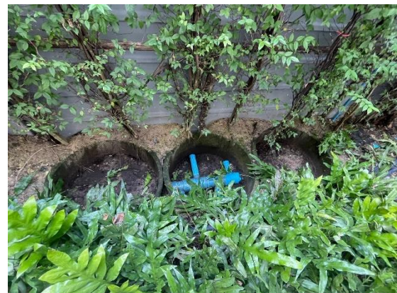
รูปที่ 8 บ่อดินบำบัดก๊าซมีเทน
